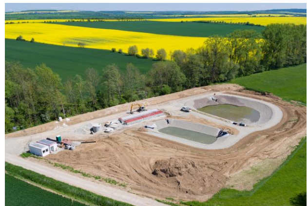
Bau der Kläranlage Schildbach
