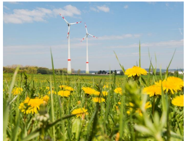
Betrieb Windpark Dingelstädt
