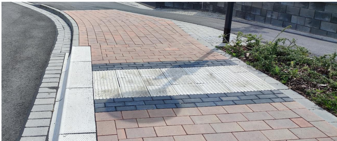
Abbildung 30: Ausbildung des Auffindestreifens an Regionalbushaltestellen ohne Einstiegsfeld (Beispiel: Hohengandern Mitte)
