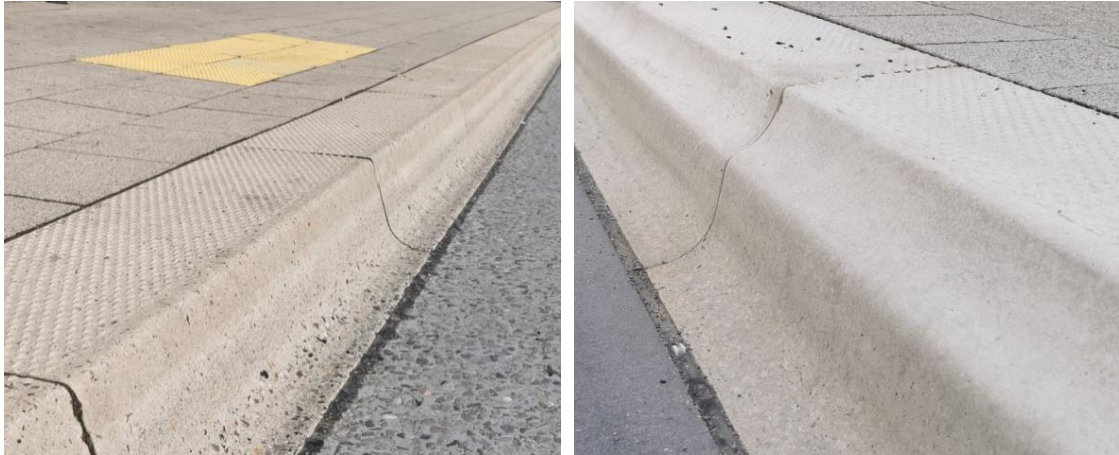
Abbildung 28: Beispiele für Sonderborde mit Spurführung (Kurven-Profil ermöglicht ein sichereres Heranfahren der Fahrzeuge an die Haltestelle); Bild rechts Sonderbord mit zweiter Hohlkehle an der Bordsteinkante zur Vermeidung von Karosseriebeschädigungen
