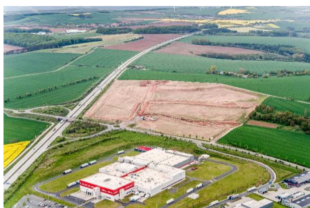
Erschließung des Gewerbegebietes „An der A38 – Ost“
