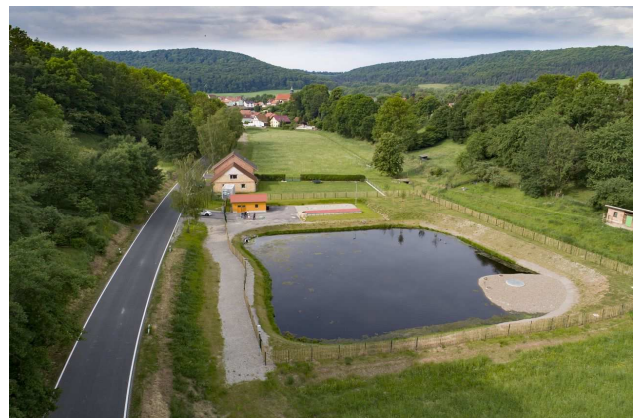
Fertiggestellte Kläranlage Birkenfelde
