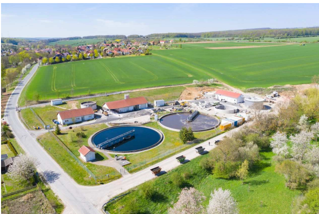
Erweiterung und Modernisierung der Kläranlage Horsmar
