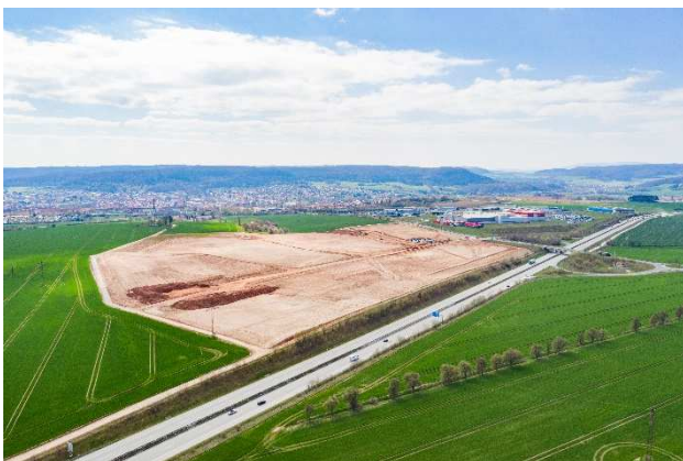
Erschließung des Gewerbegebietes „An der A38 – Ost“ in Heilbad Heiligenstadt
