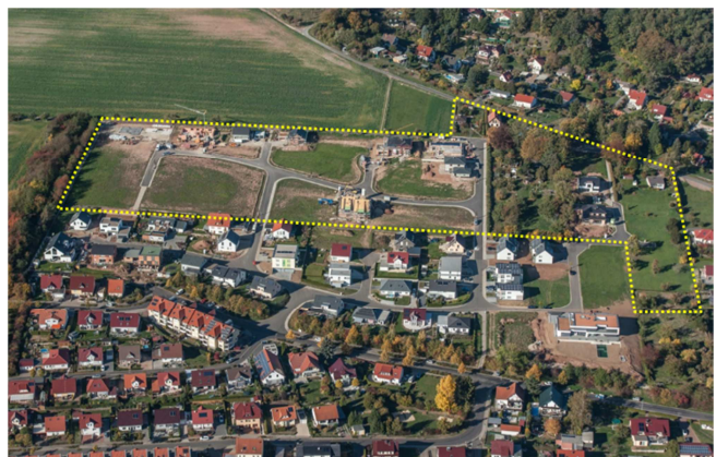
Fertigstellung der Erschließung Wohnbaugebiet „Auf dem hohen Rott – 4“
