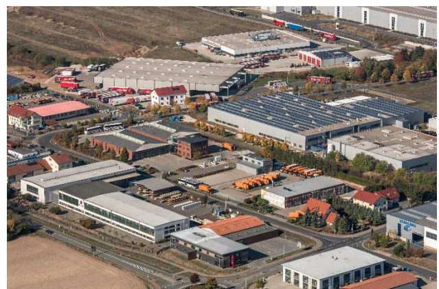
Umbau des Betriebsgebäudes in Leinefelde
