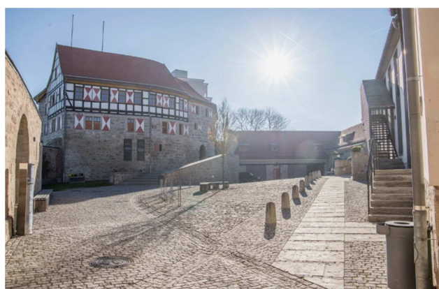
Burg Scharfenstein wird künftig über eine moderne Energiezentrale mit Strom und Wärme versorgt.
