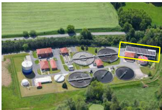
Inbetriebnahme der Photovoltaikanlage auf der Kläranlage Leinetal am 16. August 2023
