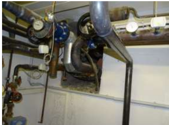
Abb. 65: Ungedämmte Wärmeverteilung II.
