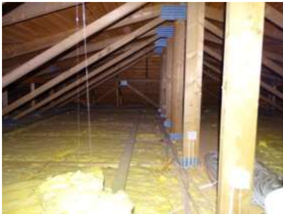
Abb. 55: Dämmung oberste Geschossdecke.
