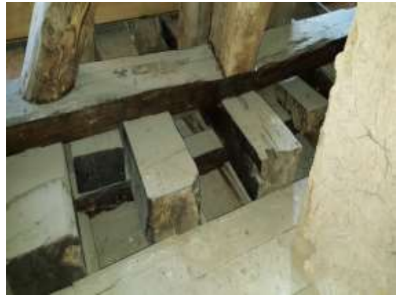
Abb. 86: Aufbau der obersten Geschossdecke.
