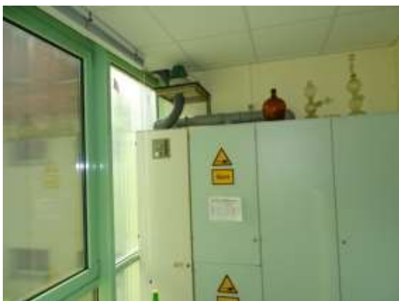
Abb. 57: Mittelbau – Folien als Sonnenschutz.
