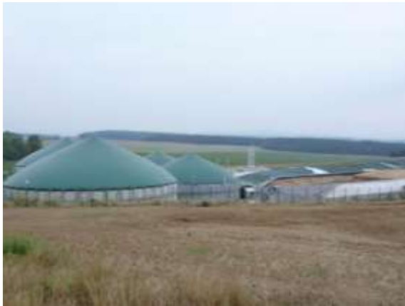
Abb. 118: Die Biogasanlage der Eichsfeldwerke bei Weißenborn-Lüderode.
