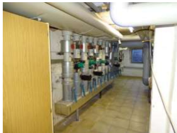
Abb. 33: Heizungsverteilung.
