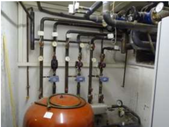
Abb. 64: Ungedämmte Wärmeverteilung I.
